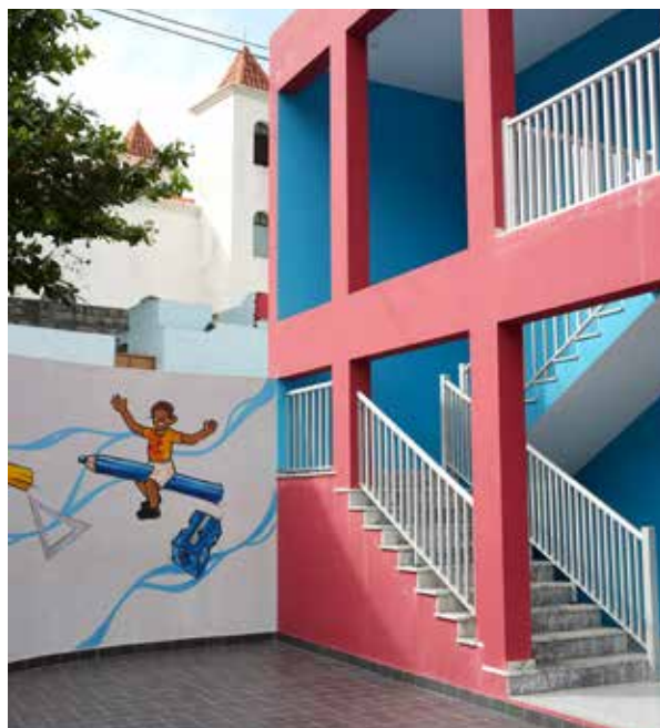
Ecole primaire à Mosteiros, Fogo, Cabo Verde
